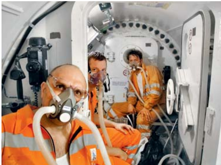
Abbildung 11 Dekompression mit Sauerstoff in der Personenschleuse einer TBM .
